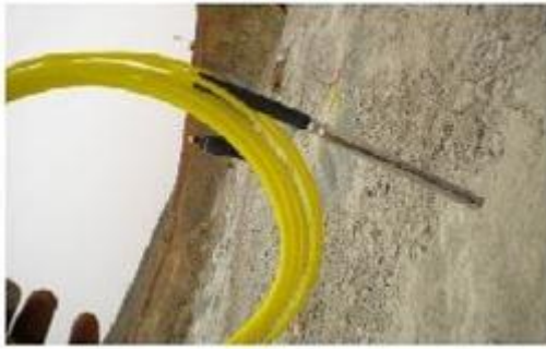
Détonateur non électrique
